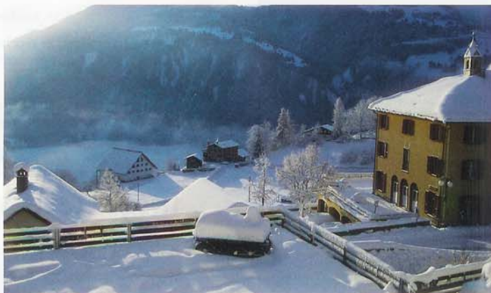
Klimagerechter Umbau in Seewis: Solarenergie wärmt den Wellnessbereich im Hotel Scesaplana (rechts) über dem Prättigau.
